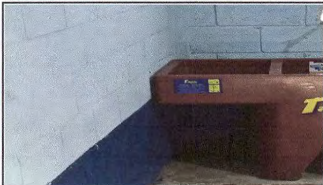
Foto 13: Sustitución de pila de cemento de dos lavaderos.
