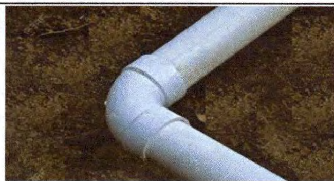
Foto 11: Sustitución de tubería PVC línea principal aguas negras.
