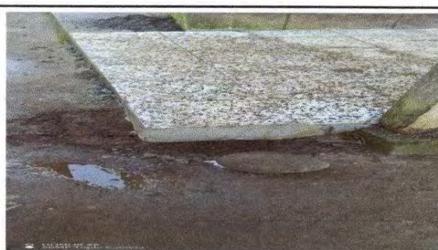
Foto 6: Sustitución de Piso cerámico.
