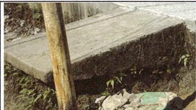
Foto 7: Reparación de cuneta de concreto.
