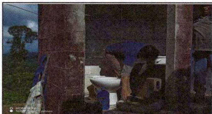
Foto 9: Sustitución de inodoro.
