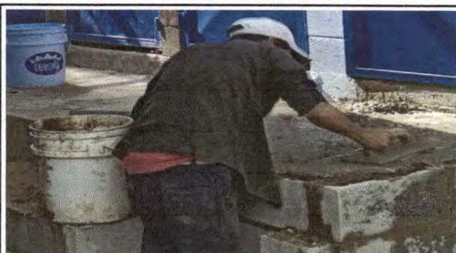
Foto 4: Reparación de piso de torta de concreto.
