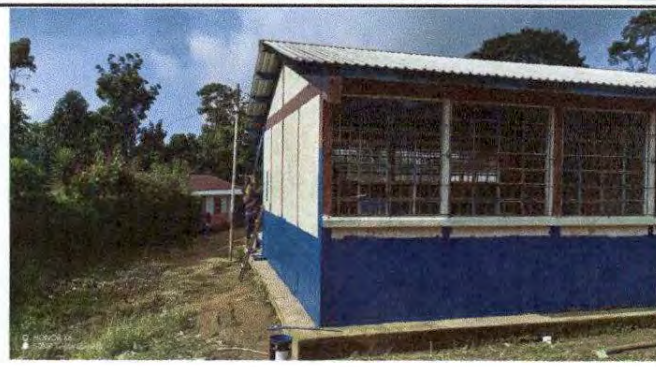
Foto 8: Pintura en muros exteriores
